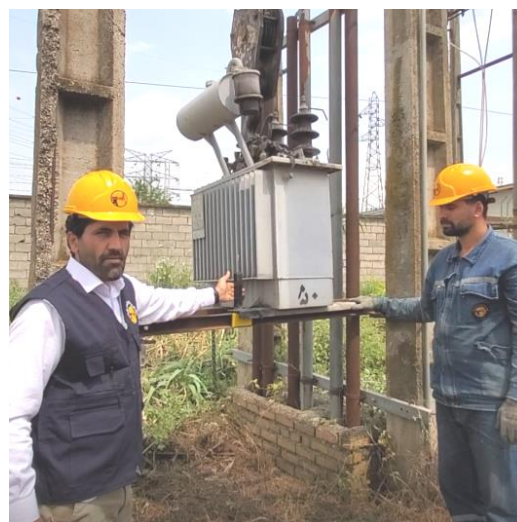
شکل ۱ مقاله: اجرای طرح در پست نمونه هوایی
