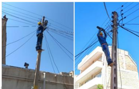
شکل ۵ مقاله: نمونه استفاده از سکو توسط سیمبانان
