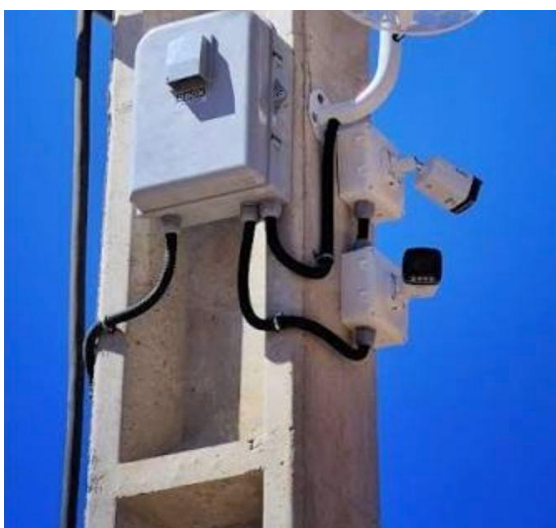
شکل ۱ مقاله: نصب سیستم به صورت پایلوت
